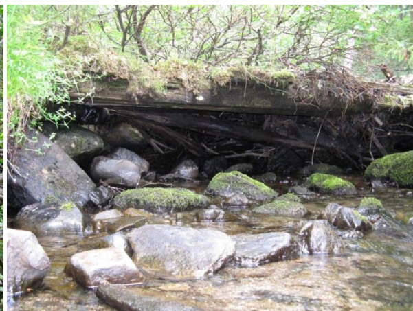
Figur 6. Övervuxen bro vid vilken ved har fastnat och nästan bildat ett vandringshinder.
