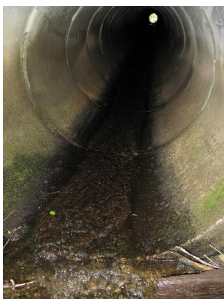
Figur 8. Uppströmssidan om den östra trumman, vatten rinner in.
