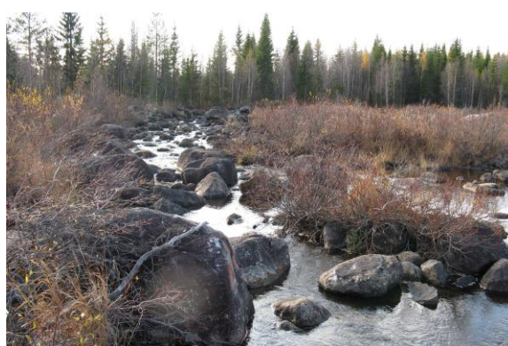
Figur 9. Objekt 4, utloppsdelat, efter åtgärd.
