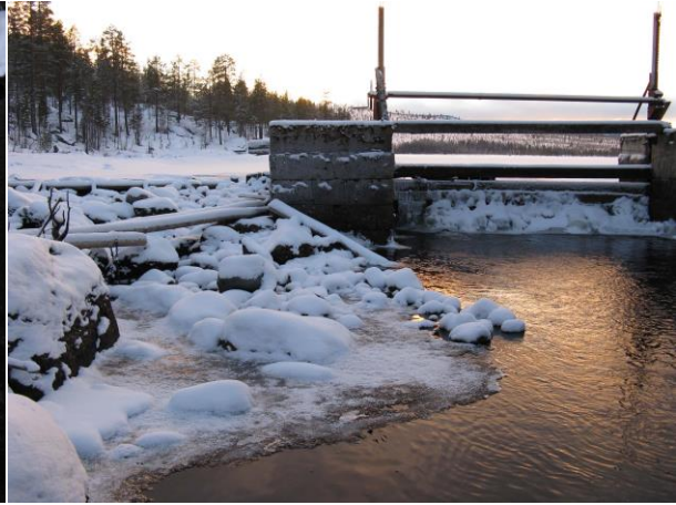
Figur 11. Joranträskdammen med torrlagd fiskvandningsväg.
