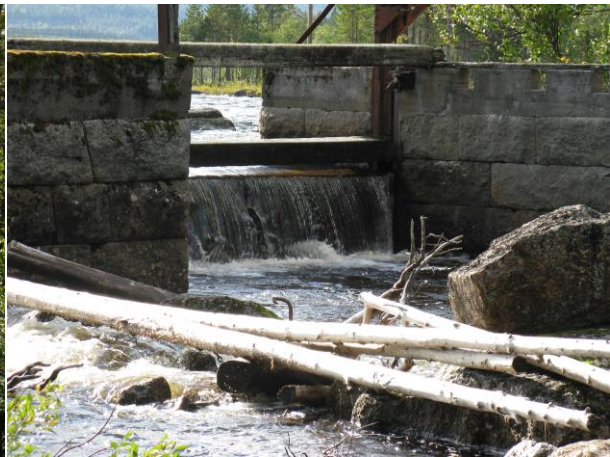
Figur 5. Kilstensdamm med träsättar.
