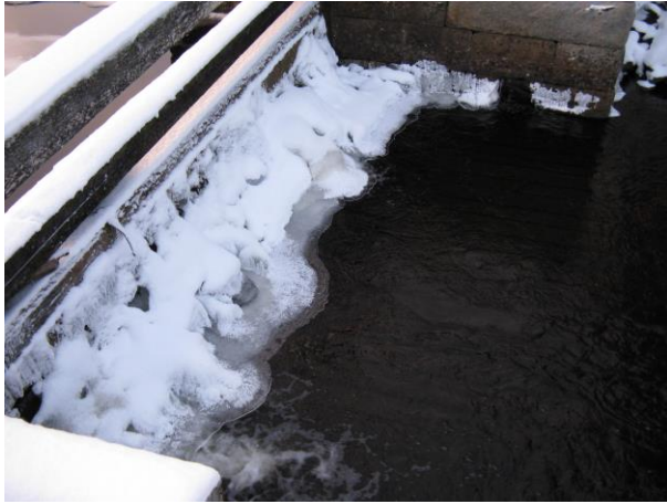
Figur 10. Läckage mellan dammsättarna.
