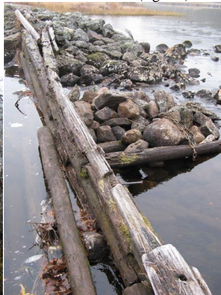
Figur 7. Närbild på stenkistan.
