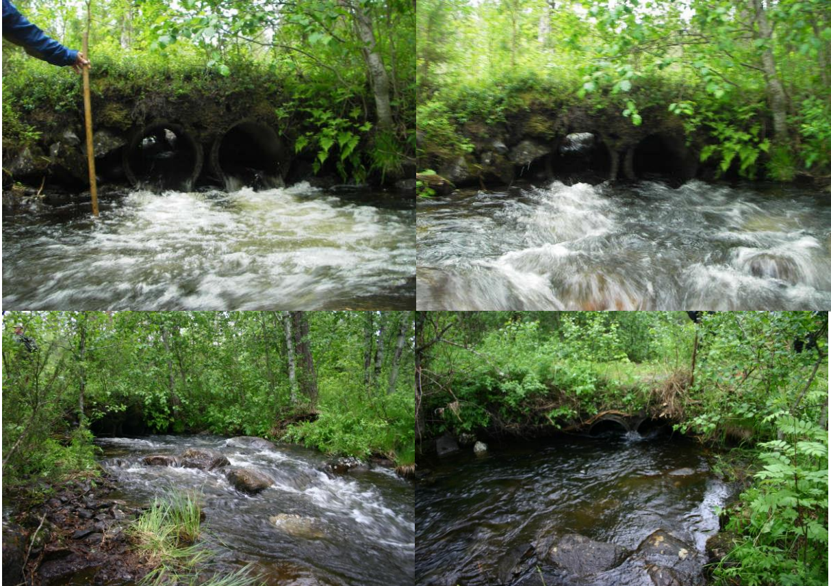
Bild 4. Vägtrumma som åtgärdades under utbildningsdagen. Bilden längst upp till vänster är trumman innan åtgärd, bilden längst upp till höger och den nedre vänstra bilden visar nedströmssidan av trumman efter åtgärd och den nedre högra bilden visar uppströmssidan efter åtgärd.
