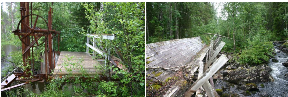
Bild 5 a och b. Dammen vid Rackokalven med bro samt rännan ca 200 meter nedströms dammen.
