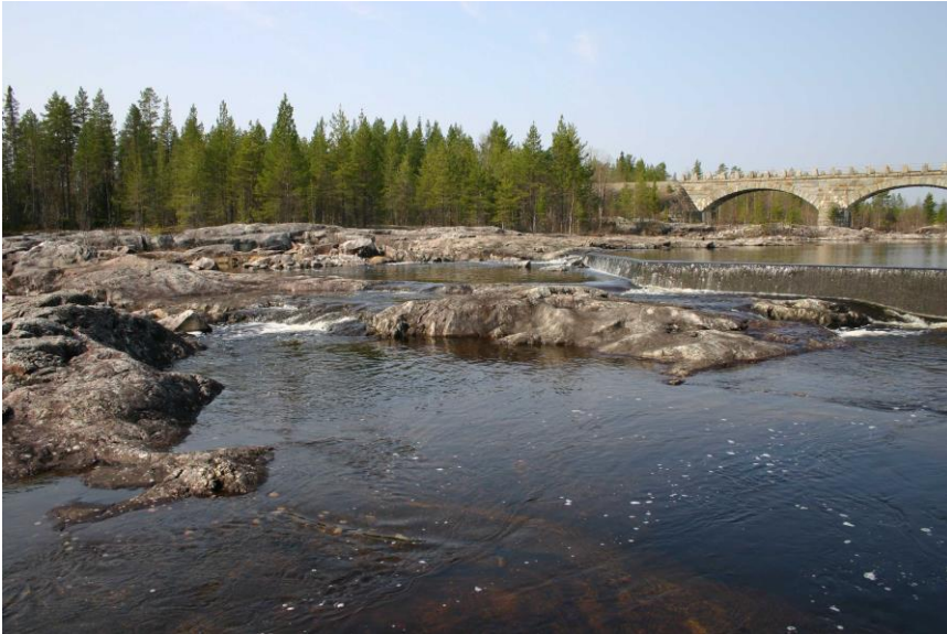
Bild 1. Vy över betongtröskeln nedanför järnvägsbron
